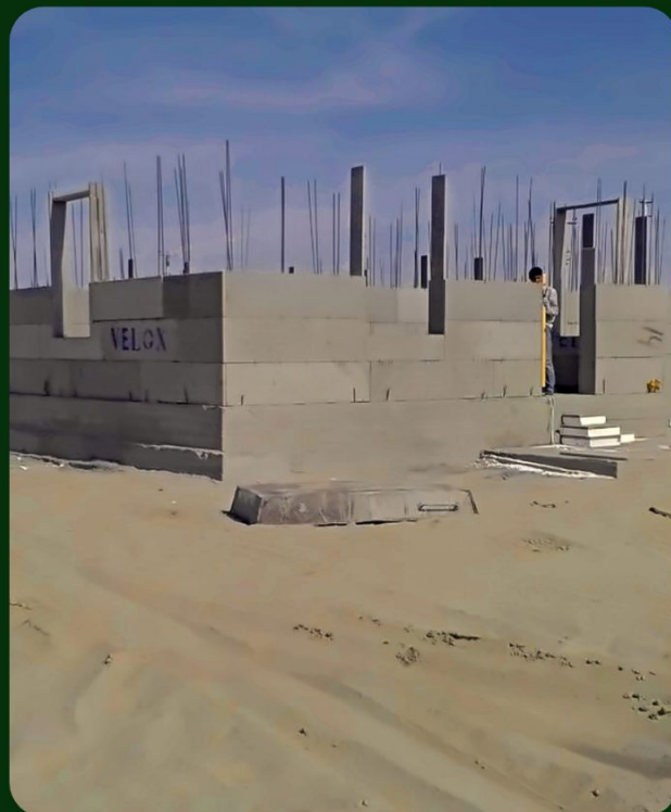
Стены. Монолит VELOX
